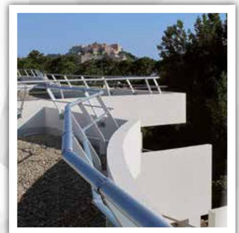
Barandilla VECTACO® inclinada con sistema de fijación a pared con desplazamiento
