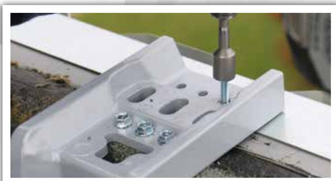
Fijación de la base Z sobre un murete metálico
